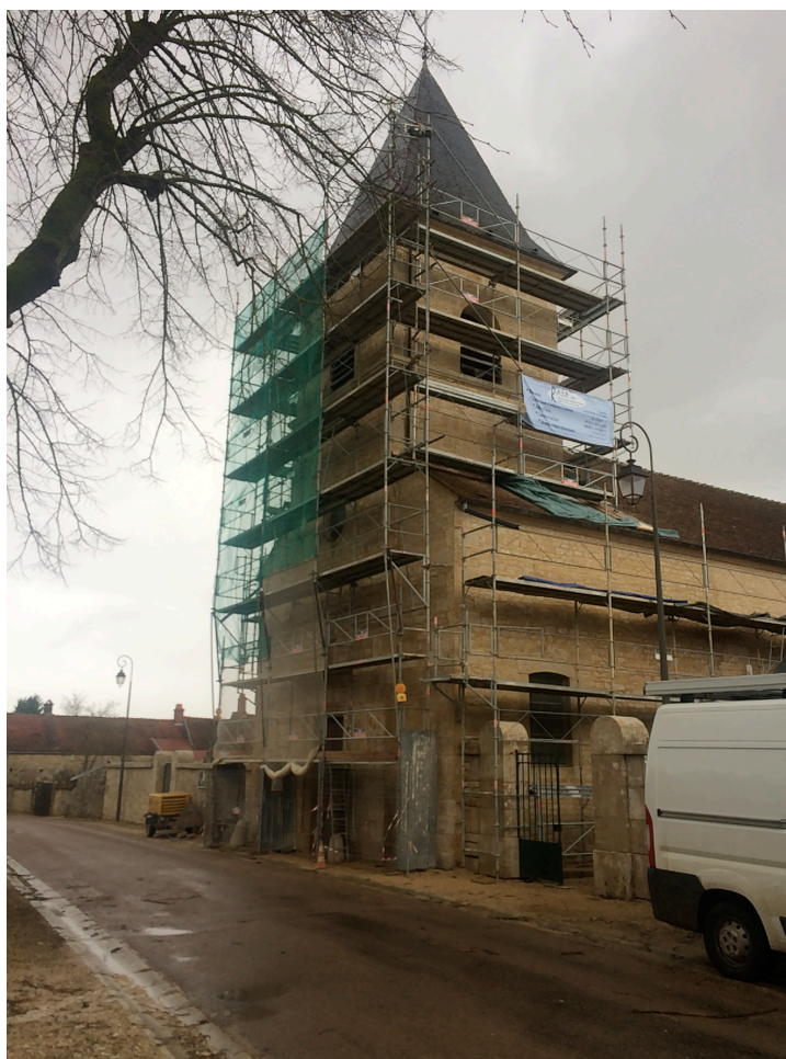
L'Eglise en travaux...
